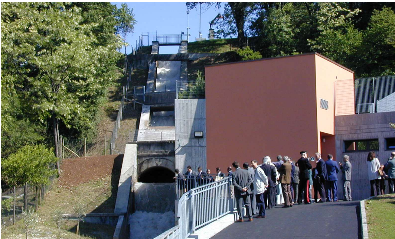
L'edificio della centrale visto da valle
